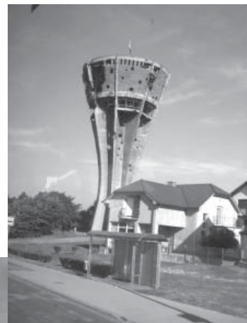
Vodotoranj – simbol stradanja Vukovara
