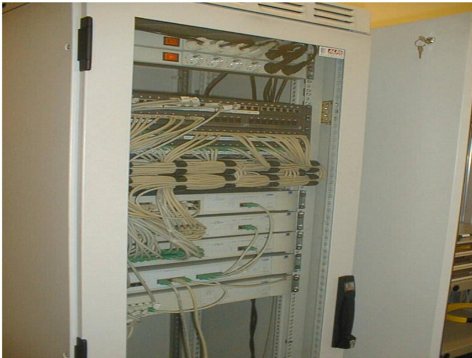
*Primjer komunikacijskog ormara s prespojnim pločama i aktivnim mrežnim uređajima*
